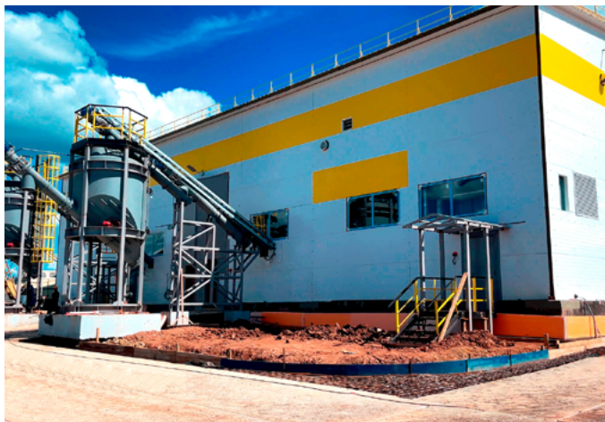
Установка термической деструкции для переработки углеводородсодержащих отходов (УТД).
