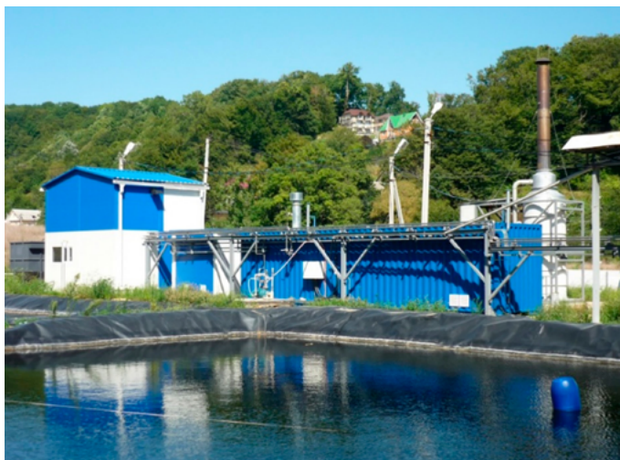
Системы очистки промышленных стоков и фильтрата полигонов ТКО (СОС). © ЗАО «Безопасные Технологии»
