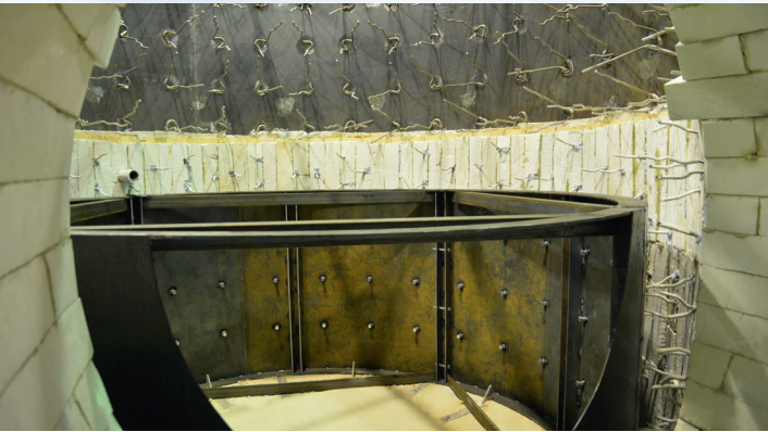
РИС. 2. Футеровочные работы трубчатой печи на производственной площадке ПГ «БТ»
