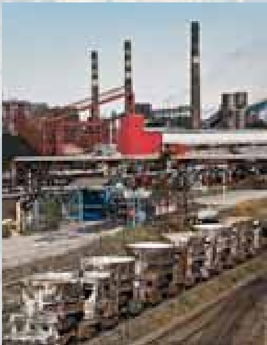
Новолипецкий металлургический комбинат www.rusindustry.ru
