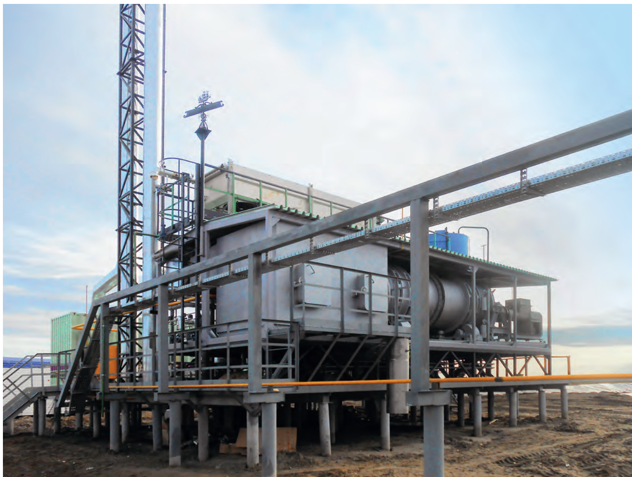
Комплекс термического обезвреживания ПГ Безопасные Технологии
