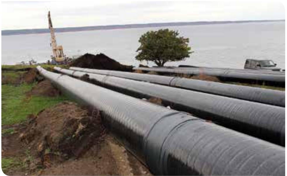
Технология «ЗУБ» позволяет наносить покрытие на стальные, полимерные, чугунные трубы, трубодетали и стыковые соединения PCWC can be applied to steel, polymer or cast iron pipes, pipe components and joint assemblies
