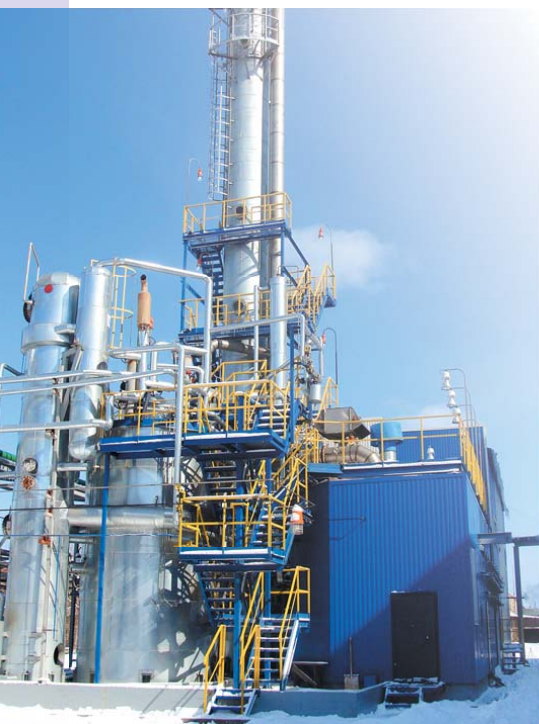
Установка безметанольного формалина, промплощадка ОАО «Уралхимпласт»
