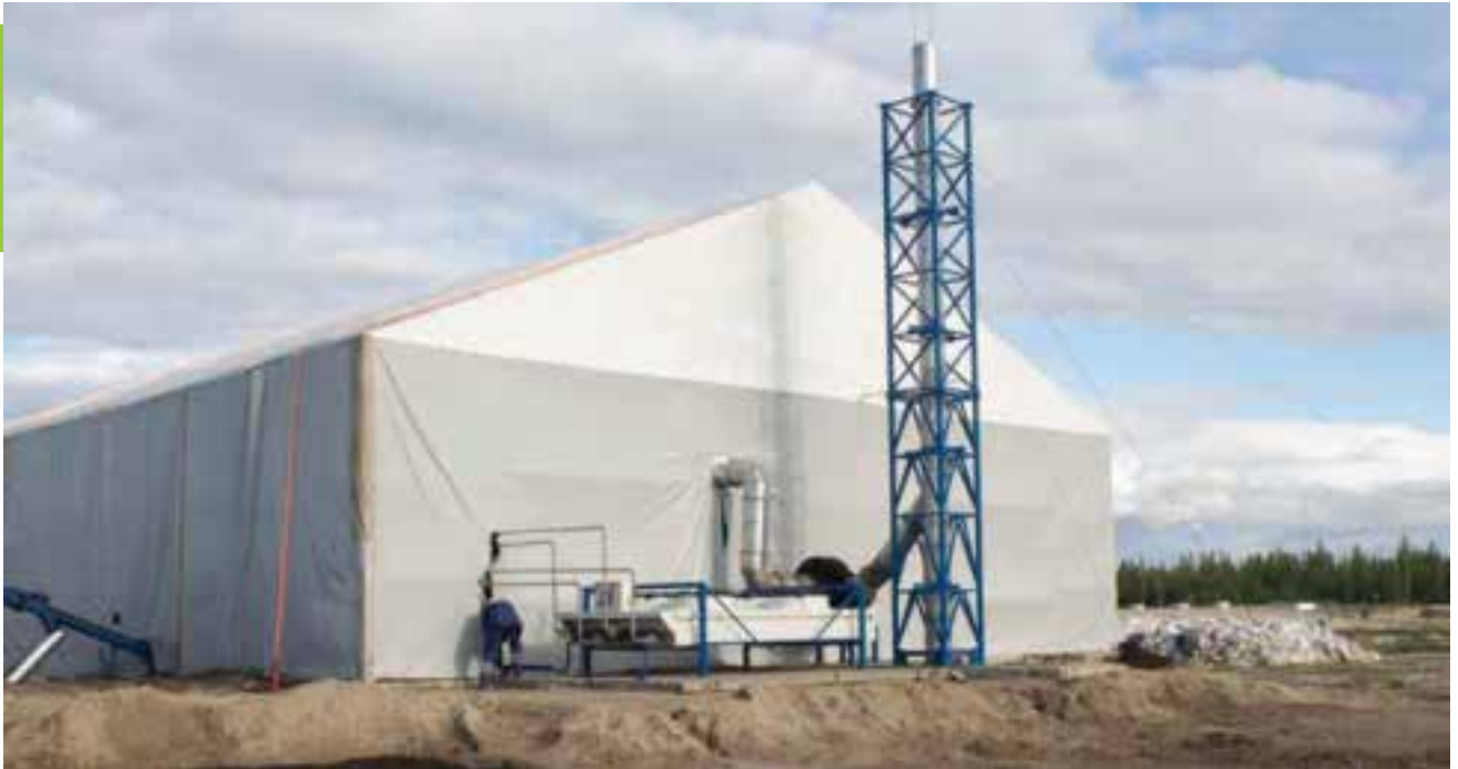
Установка непрерывного пиролиза углеводородосодержащих отходов. Вынгапуровское НМ, Тюменская область
