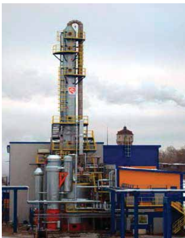
Установка производства формалина 30 тысяч тонн в год производства ПГ «Безопасные Технологии», ФКП «Завод им. Свердлова»
