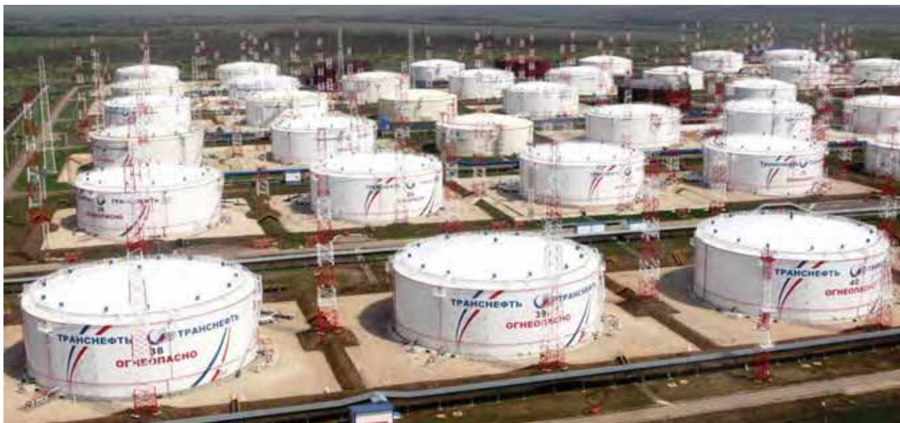
Резервуарный парк Самарского районного нефтепроводного управления ОАО «Транснефть». www.pmn.transneft.ru
