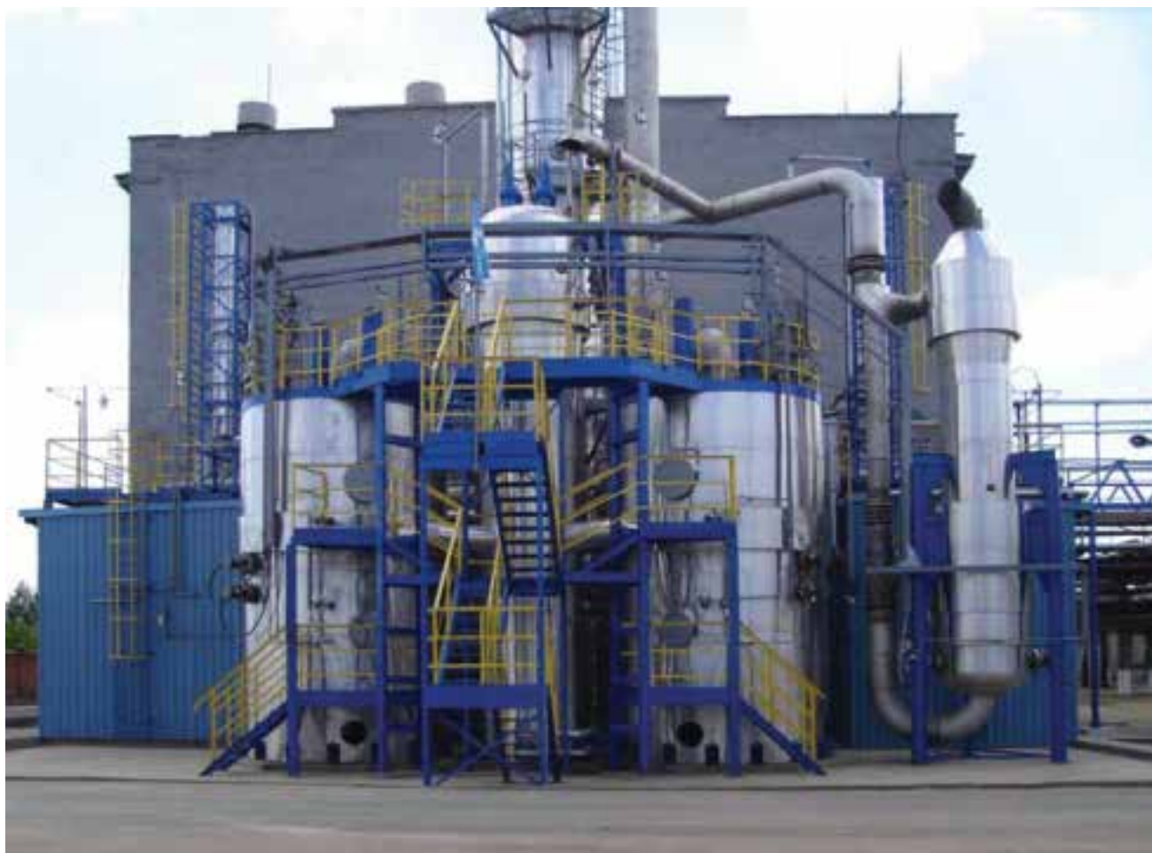
Двухреакторная установка формалина/КФК 80 тысяч тонн в год производства ПГ «Безопасные Технологии», ОАО «Щекиноазот»
